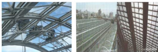
図 22 遮熱塗料の施工
