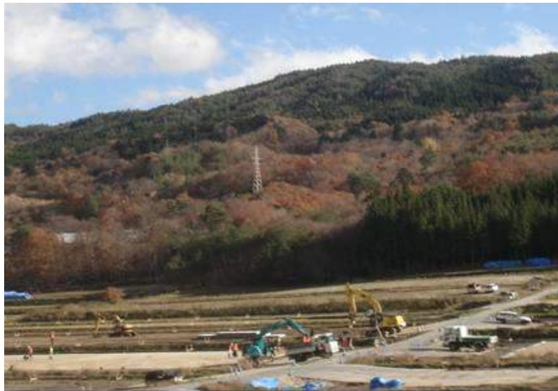
写真3. 飯舘村村内の放射性物質汚染の著しい水田除染の状況（2013年11月21日撮影）
