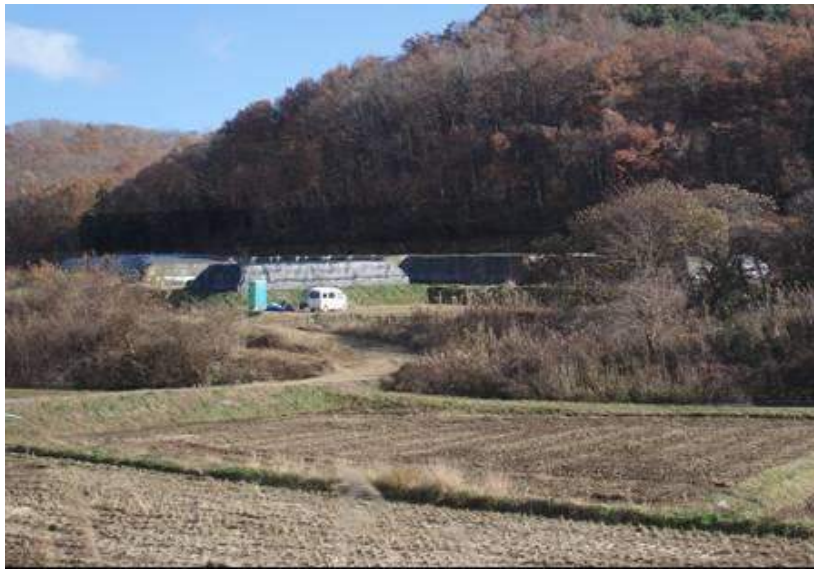
写真5. 除染後の廃土を貯蔵する簡易型除染廃土仮置き場の状況（2013年11月21日撮影）
