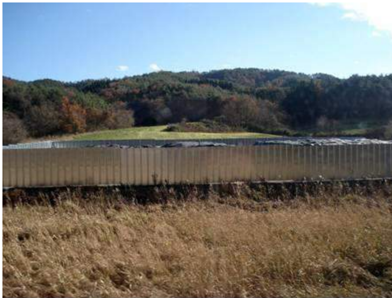
写真6. 比較的管理の厳格な除染後廃土仮置き場の状況（2013年11月21日撮影）
